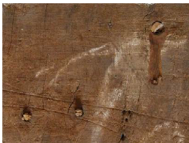
Fig. 23 – Incredulidade de São Tomé – Preenchimentos com cavilhas no verso do painel (Fig. 20 – pormenor 1). ©. Maria João Sousa.
